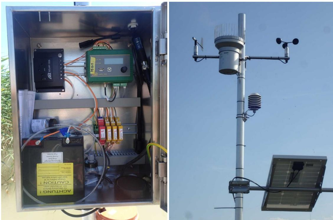
**Abb. 9. Schaltkasten der Wasserqualitätsmessstationen für die Elektroinstallation (links) und Solarpanel mit den bei IL2on und MO2on eingebauten Meteorologie-Sensoren (rechts).**
