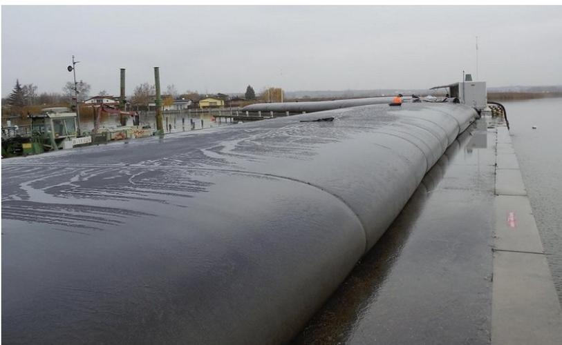
**Abb. 30. Geotubes zur Entwässerung von entnommenem Sediment. Foto: Böhm Transporte (2020).**
